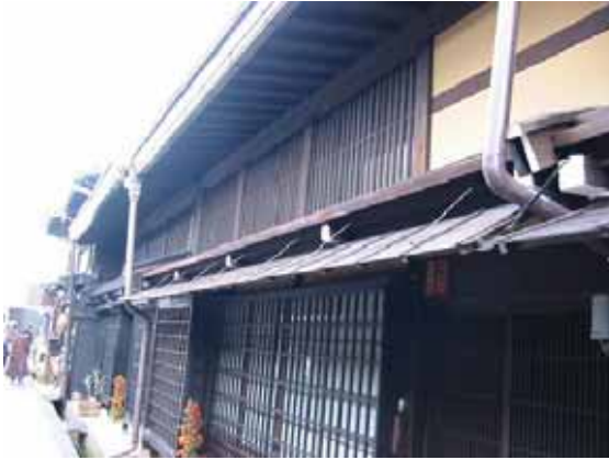
1階の出格子と2階の連子の様子
