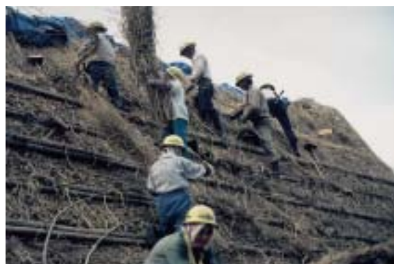
相倉集落屋根修繕
